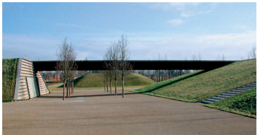
Abb. 32: Fußgängerbrücke am Kiosk, Potsdam
