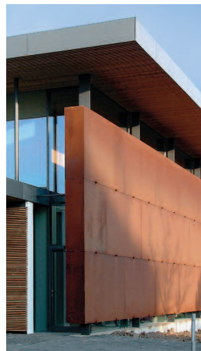
Abb. 28: Linke Seitenwand mit Fassadenblechen aus Wetterfestem Stahl. Die Keil-Pressverbindungen, mit denen die Bleche in einem Abstand von 75 cm fixiert sind, sind als Punkte gut sichtbar. Die Lichtbänder am Fuß und am Kopf dieser Wand sind verglast.
