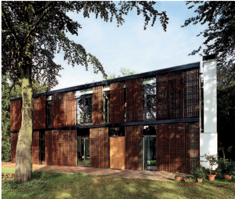
Abb. 20: Westfassade mit stockwerk hohen, verschiebbaren Sonnenschutzelementen mit Gitterstruktur aus Wetterfestem Stahl
