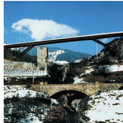
Abb. 36: Dalabrücke, Rahmenbrücke mit geneigten Stielen
