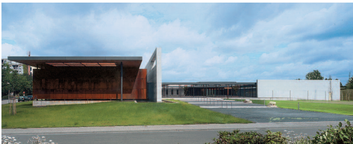
Abb. 27: Gemeindezentrum Herz Jesu in Völklingen-Ludweiler. Links von der hohen Betonscheibe ist die Kirche angeordnet. Die Sichtflächen der Frontwand (im Bild zu sehen) und der linken Seitenwand bestehen außen und innen aus Wetterfestem Stahl.
