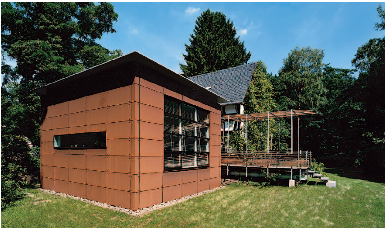
Abb. 23: Fachwerkhausanbau mit Fassadenplatten aus Wetterfestem Stahl
