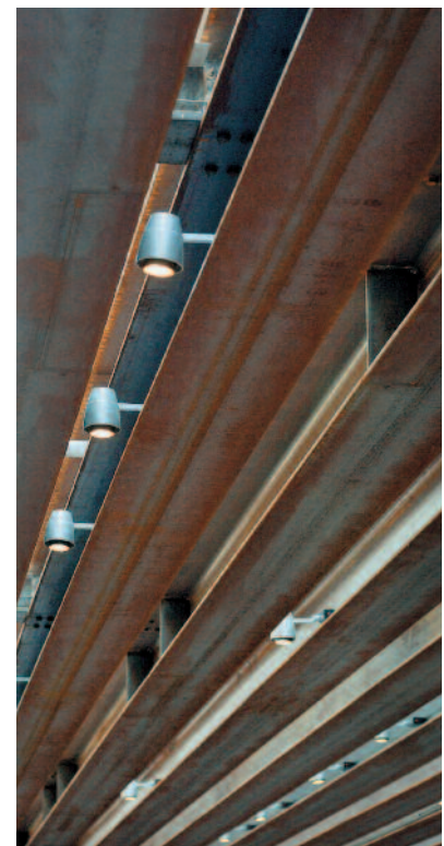
Abb. 19: Sichtbare, vollwandige Dachträger im Innenraum
