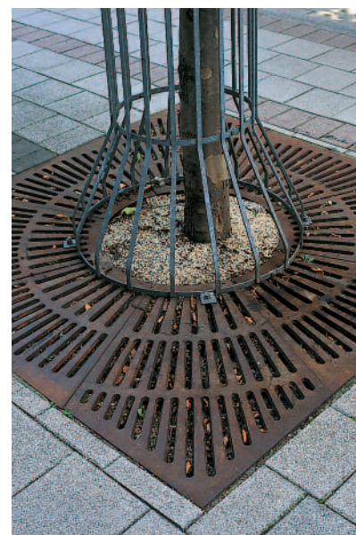
Abb. 50: Gusseisernes Gitter mit natürlicher Rostfärbung zur Abdeckung einer Baumscheibe im Bereich eines städtischen Gehweges
