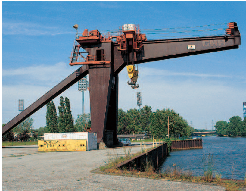
Abb. 49: Schwerlastkran mit 450 t Tragkraft am Hafenbecken in Oberhausen
