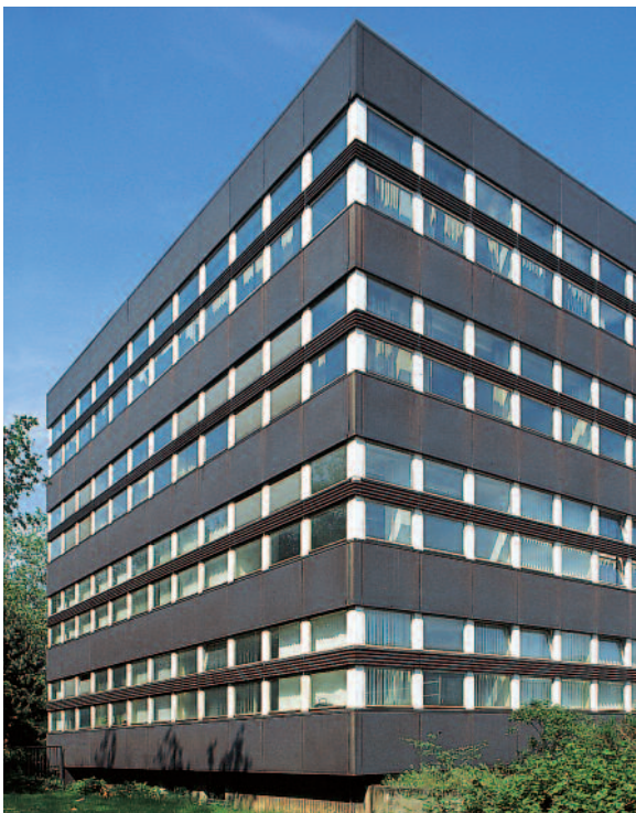
Abb. 25: Fünfgeschossiges Hauptgebäude eines Forschungsinstitutes mit einer Fassade aus Wetterfestem Stahl
