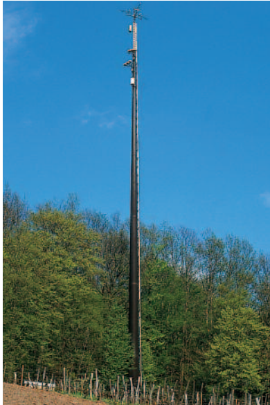
Abb. 44: Fernsehumsetzer. Etwa 100 Exemplare wurden von der Post um 1980 gebaut. Höhe zwischen 60 und 70 m, Blechdicke des Rohrquerschnitts 10 bis 15 mm.
