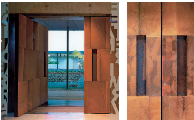
Abb. 30: Zweiflügelige Eingangstür der Kirche: Ansicht von innen und Detail von außen im Bereich der Tür(ein)griffe
