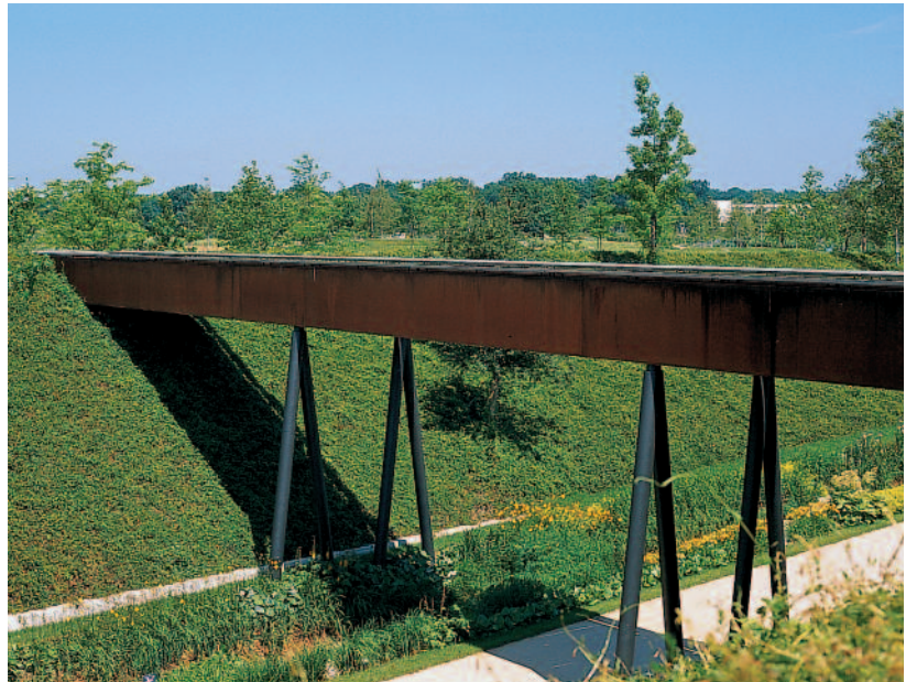
Abb. 31: Brücke mit Zwischenstützen
